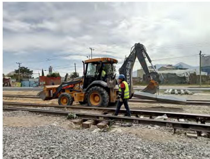
Suministro de durmiente de concreto para vía TS, Blvd. Tultitlán/Av. 2
