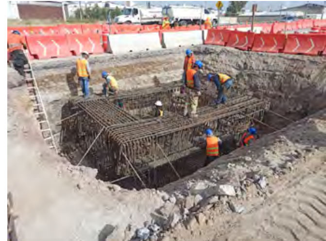
Habilitado de acero para zapata en eje B
