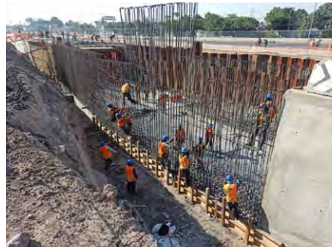
Habilitado de acero para muros Río de los Remedios
