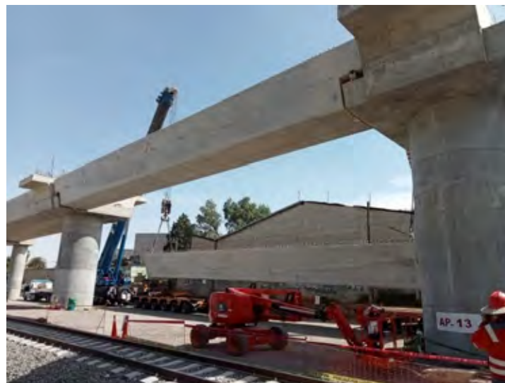
Av. 11 de Julio / Calle Olivo- Montaje de trabe del apoyo
