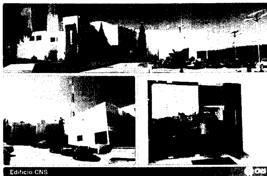
Figura 2. Vistas exteriores del Centro de Datos del Centro Nacional de Supercómputo, del IICYT A.C.
